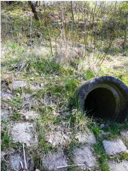
Foto x, 29.04.09, øst for sø syd for P-plads, befæstning omkring gammelt rørudløb
