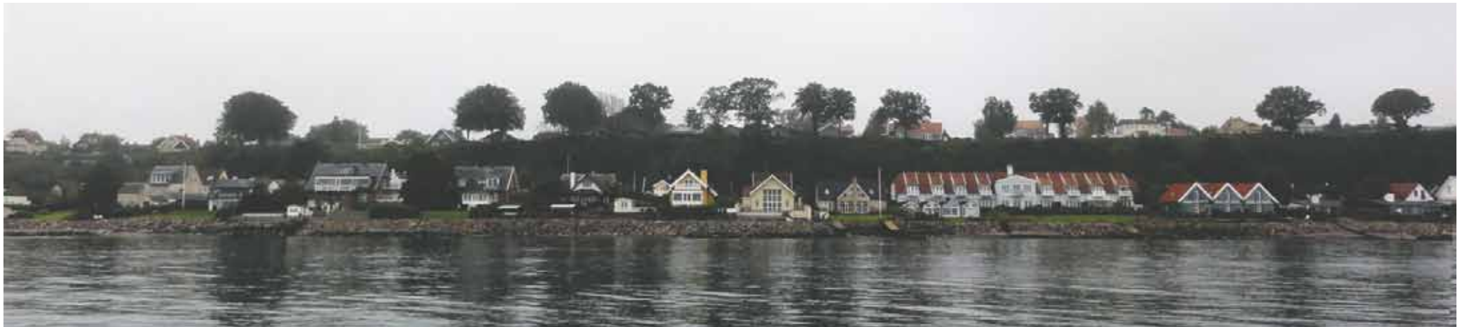
Kystskrænten ved Ålsgårde med bebyggelse på forlandet foran skrænten og helt oppe på toppen
